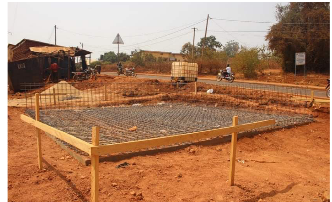
Construction d'un point de collecte de déchets
